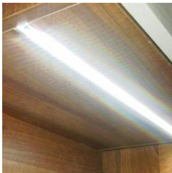
PS4, VS8 Led pásek nové svítidlo liniové- zapuštěné 4000K al. profil, krytí difuzor, zafrézováno 3,8bm + 4,5bm
